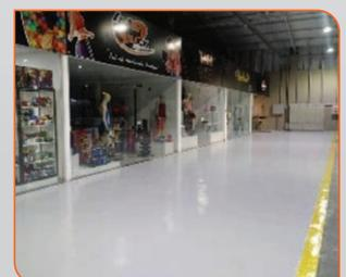
Acabamento com Pintura Epóxi
